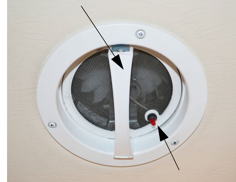
Fan Power Switch
